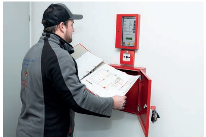
Vorgeschriebene Eigenkontrolle von Brandschutzeinrichtungen
